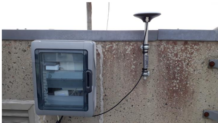
Figure 2 : Base Centipède sur le toit de l'IUEM.
