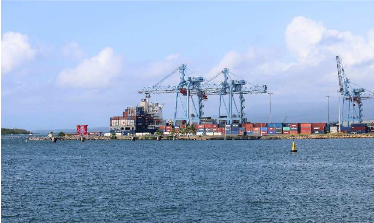
Photo 1 : Terminal à conteneurs du port de Jarry.
