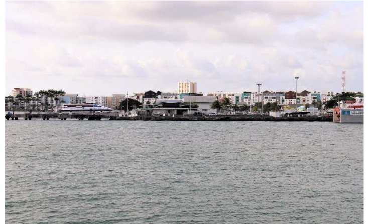
Photo 2 : Gare maritime de Bergevin, Pointe-à-Pitre.
