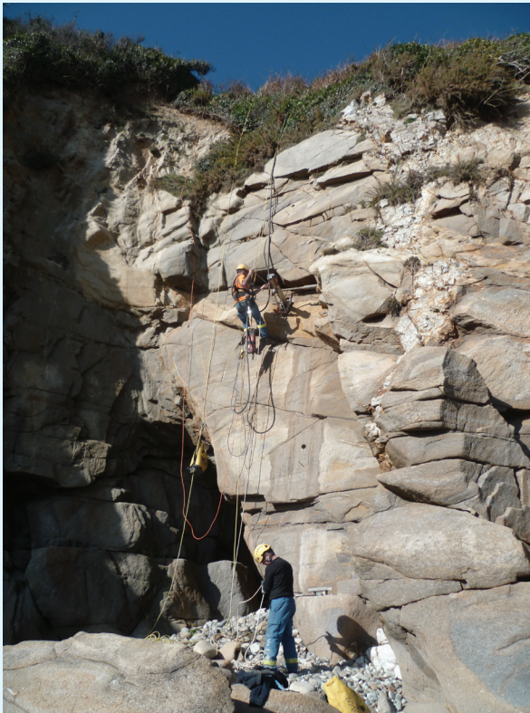
Forage réalisé par les cordistes pour la mise en place d'un des trois géophones horizontaux.
