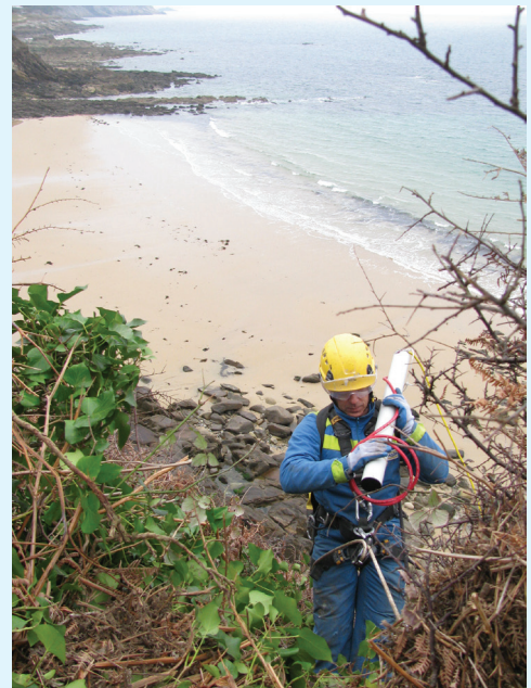
Descente à partir du haut de falaise d'un des géophones horizontaux pour son installation dans le massif rocheux .
