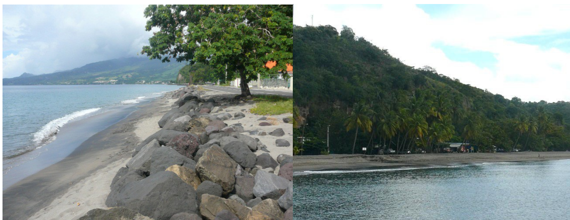
Enrochement à l'extrémité nord du Carbet (à gauche) et plage sableuse du Coin au sud du Carbet (à droite)
