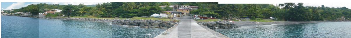
Panoramique au niveau de la jetée du quartier du cimetière. On note la présence d'une petite plage sableuse au sud de la jetée.
