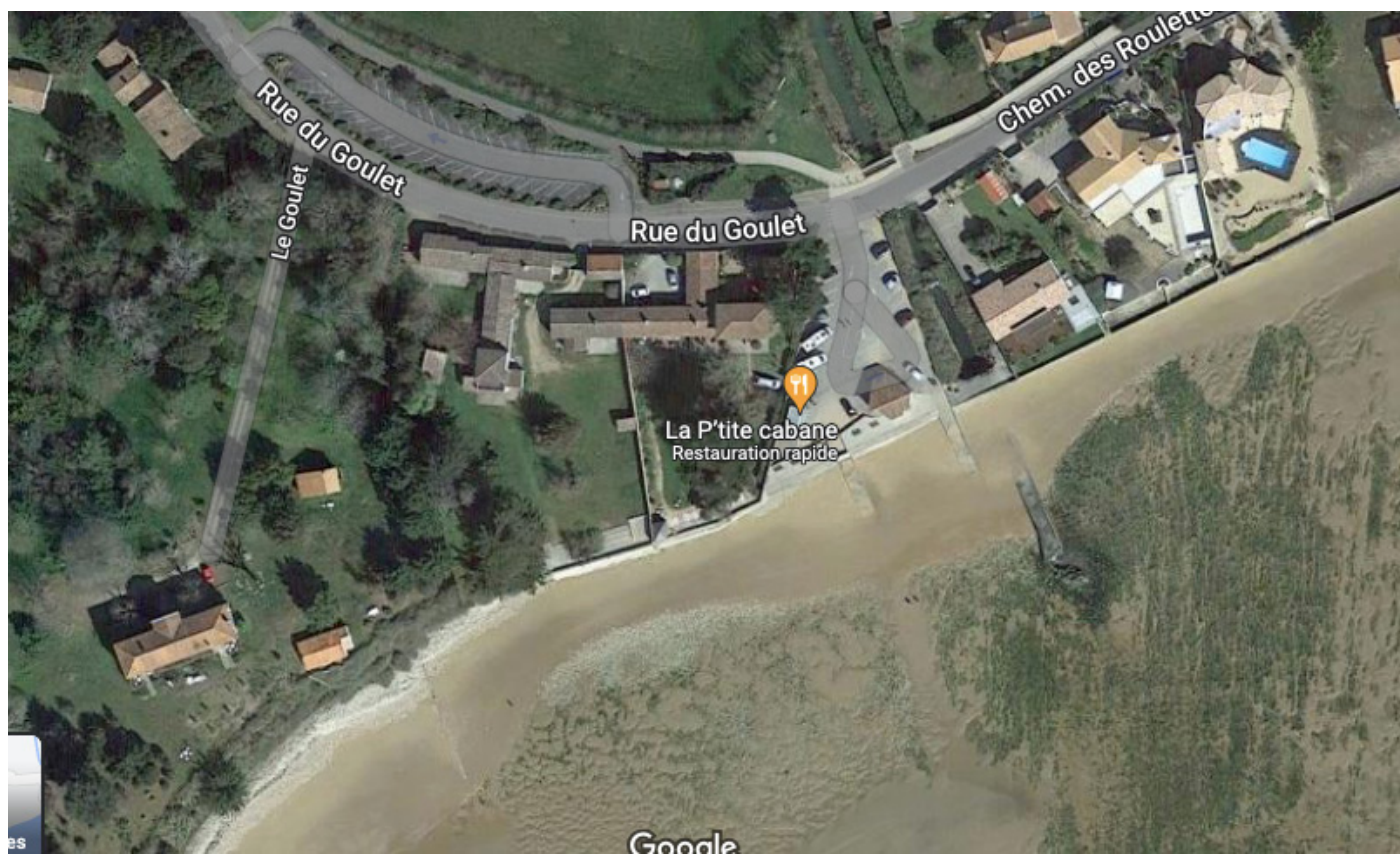
Figure 43 : zoom sur le secteur autour de la P'tite cabane avec ses épis, perré bas, rampes d'accès et émissaire d'écoulement du Goulet
