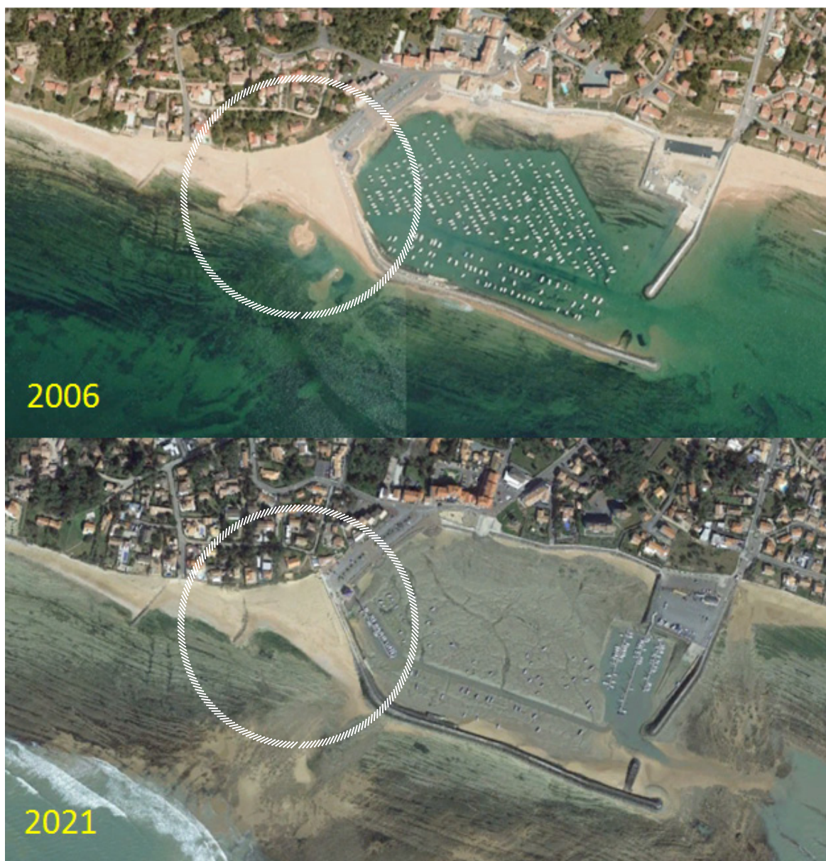
Figure 39 : transit sédimentaire bloqué en amont de la digue du port de Jard sur Mer et débordement du transit qui est propulsé plus au large et peut ne pas revenir vers la plage en aval.
