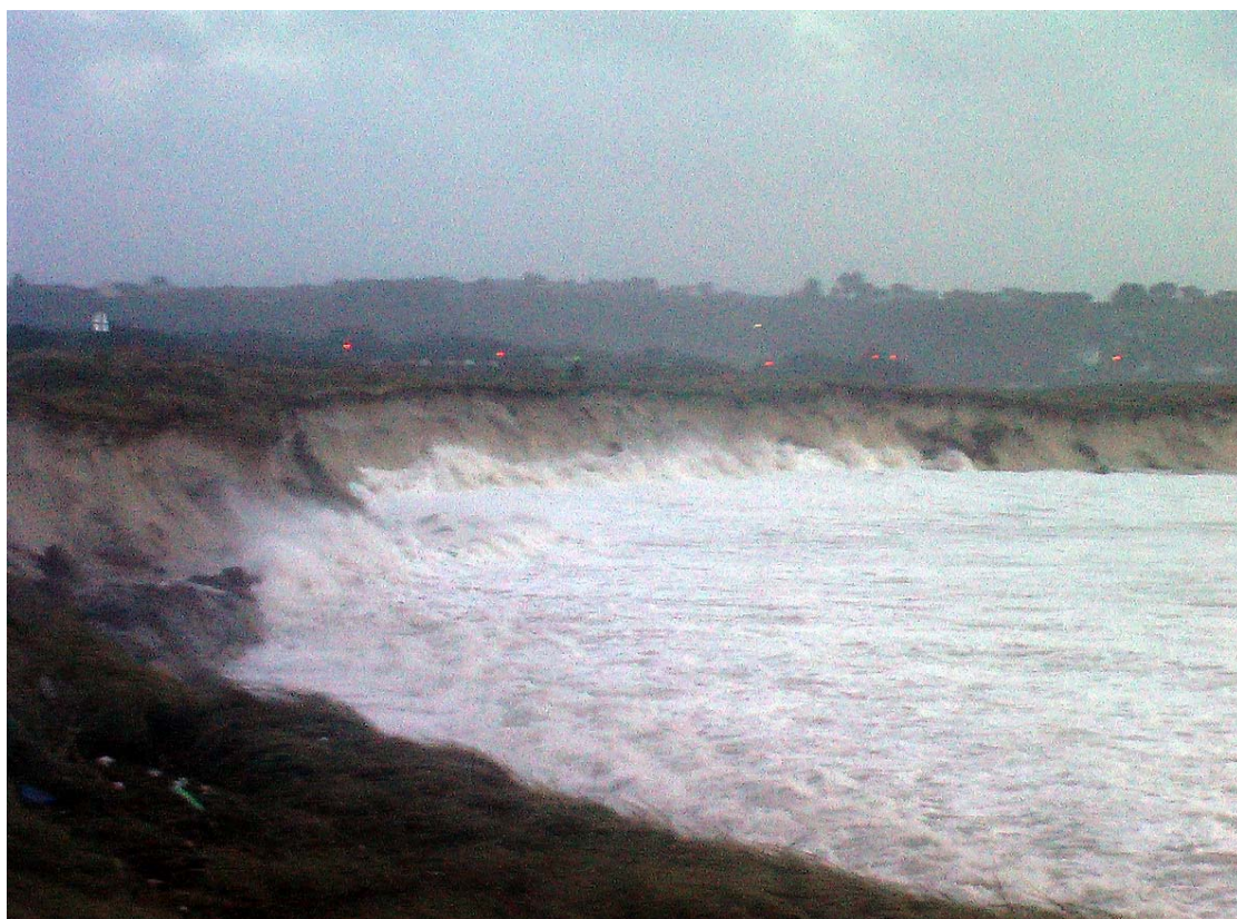
Photo 2 – Enrochement en pied de dune (à l'est de la radiale 01) submergé par le déferlement des vagues (10/03/2008 – 19h30)
